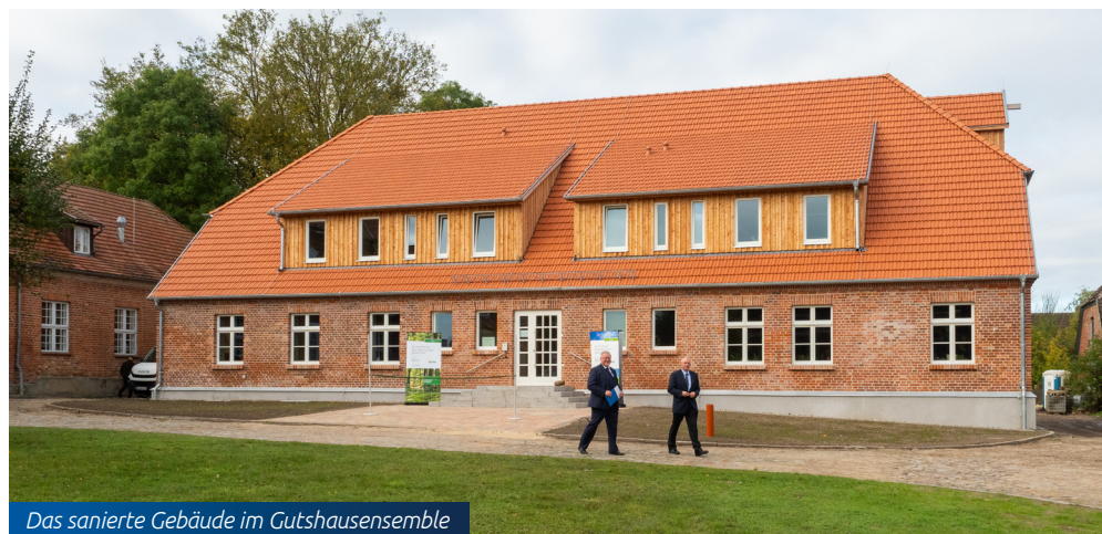
Das sanierte Gebäude im Gutshausensemble
