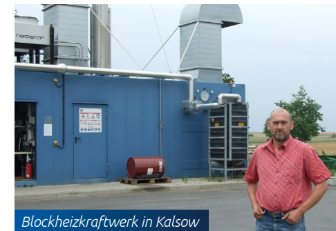
Blockheizkraftwerk in Kalsow
