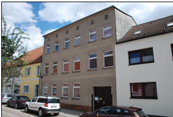
Ansicht Wohnhaus Mühlenstr.65
