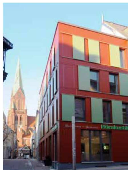
Schlossquartier: Rekonstruktion der denkmalgeschützten Bausubstanz und moderne Bebauung des ehemaligen Uhlenquartiers, Architekten: Büro Joedicke-Leinberger-Schneider Freie Architekten Foto: LGE
