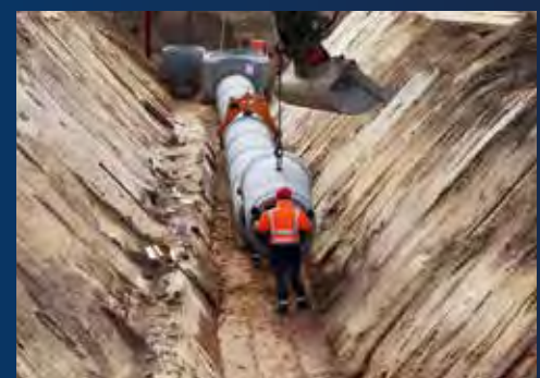
Erschließungsarbeiten in Schwaan „Böhlenrade“
